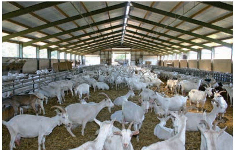
Ein Stallneubau mit Jalousienlüftung ermöglicht ein ideales Raumklima rund ums Jahr.
